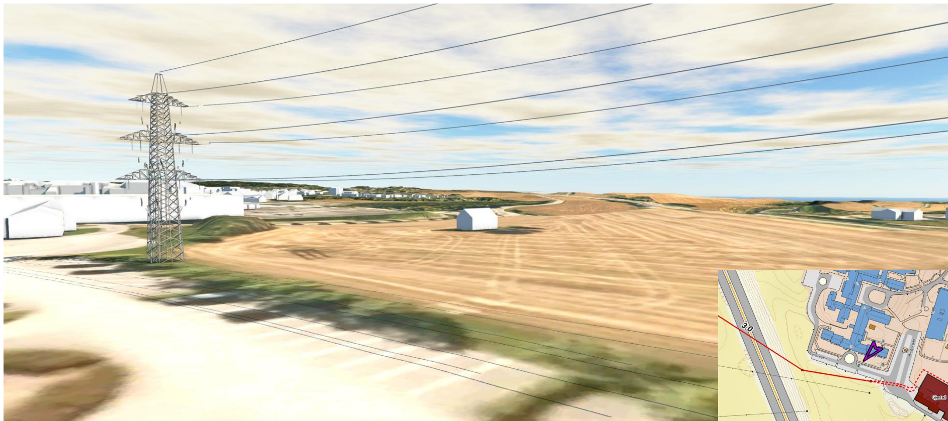
Illustrasjon 1. Kabelendemast (3.0) ved Gjestad sett fra markering i kartutsnitt (nede høyre).
